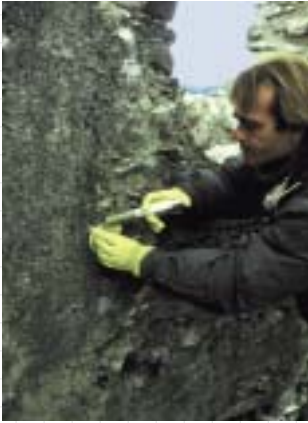
Thomas Starke, Restaurator und Leiter eines Filialbüros bei der Sicherung des Putzes.
