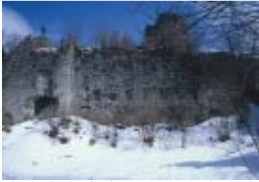
oben: Westtrakt (Tortrakt) der Kernburg vor und nach (rechts) der Sanierung.
