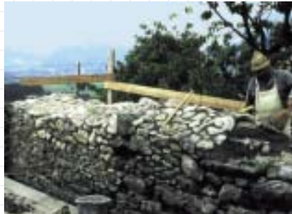
unten: Das Aufmauern der neuen Mauerkronen am Westtrakt der Hauptburg.
