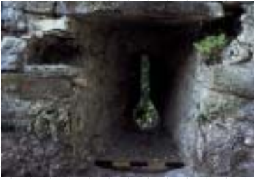
Schlüsselscharte aus Tuffstein in der Vorburg (um 1490). Daneben das steingerechte Aufmaß (Detail Innenansicht) einer anderen Schlüsselscharte (um 1510).
